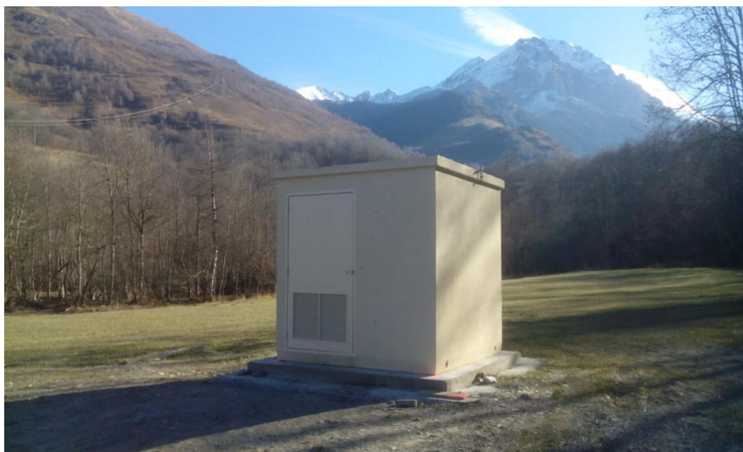
Plateau technique de pompage, aspect final
